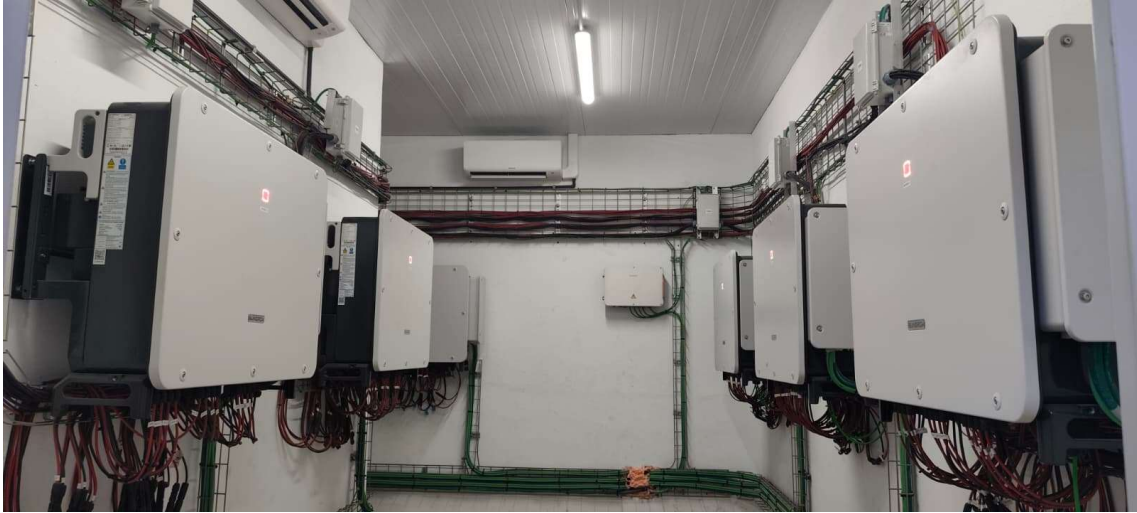
SALA INVERSORES SUNGROWS Modelo SG125CX-V112
