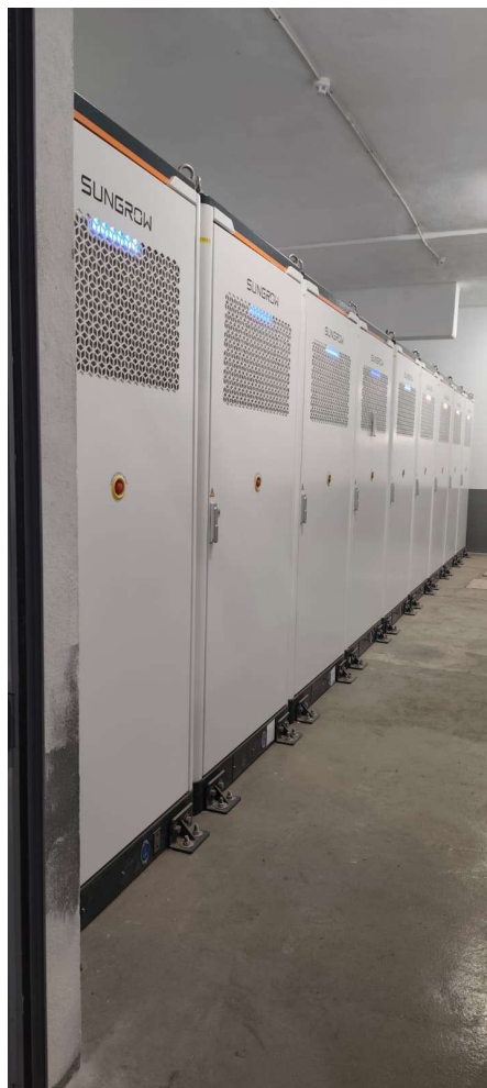
SALA INVERSORES SUNGROWS Modelo SG125CX-V112
